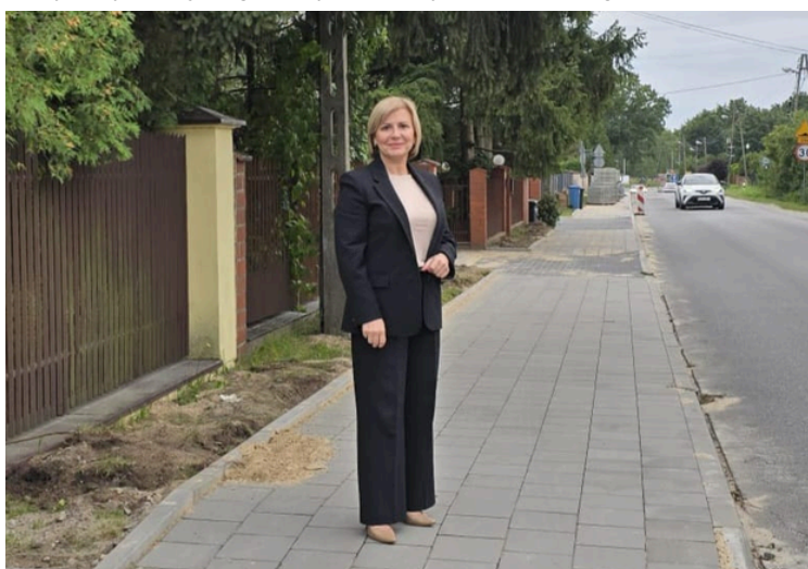
Trwa II etap budowy chodnika na ul. Klonowej
